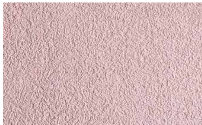
Штукатурка Ceresit CT 72, зерно 1,5 мм, получена путем затирания пластиковым полутерком (теркой).
